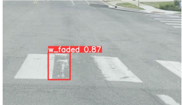
(d) Faded white crosswalk marking
