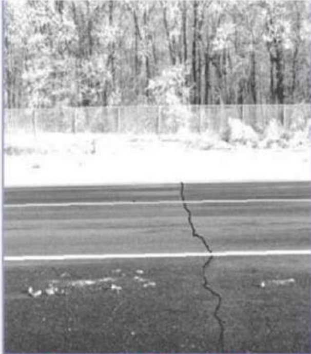
Thermal Cracking
