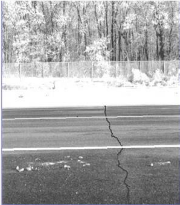
Thermal Cracking
