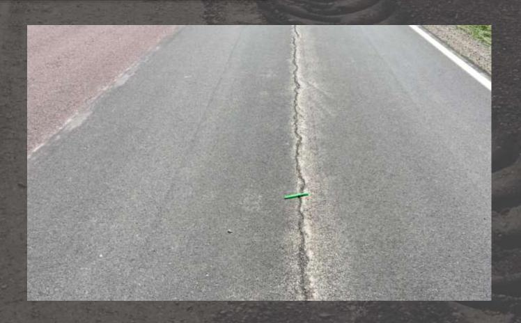
LONGITUDINAL CRACK POSSIBLY FROM MILLING
